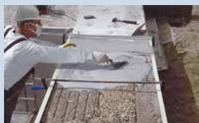
Application de mortier
